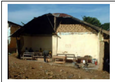
Destruction des maisons (nouvel axe de routier)
