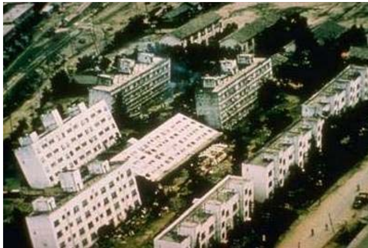
Figure 7 : Bâtiments qui se sont enfoncés suite au tremblement de terre de Niigata au Japon le 16 juillet 1964 10
