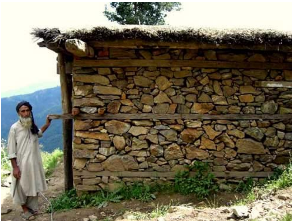
Figure 15 : Construction traditionnelle en « batar »
