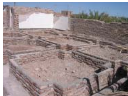
Fondations réalisées par Caritas Suisse
