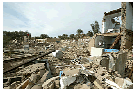
Bam, avant le déblayage des décombres.
