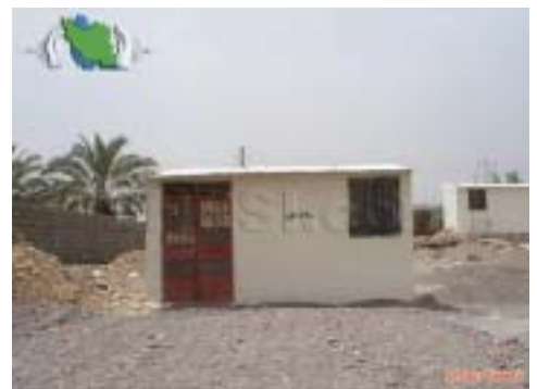
Préfabriqués situés en périphérie de la ville de Bam.
