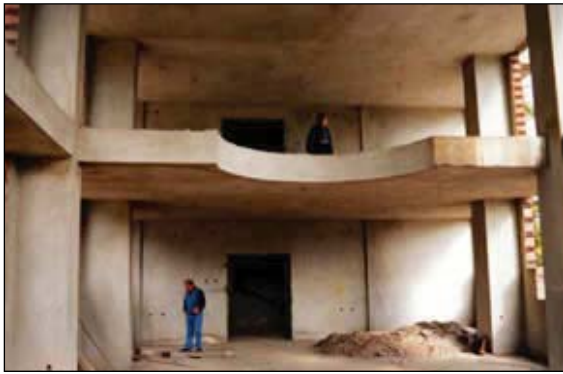
Photo prise lors du chantier de réhabilitation
