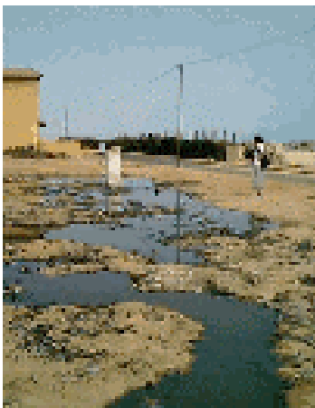
La canalisation municipale qui ne dessert qu'une partie du nouveau bloc de Yofif déverse très souvent ses eaux dans la rue
